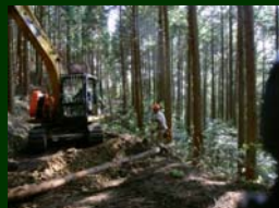
(丸太で横断溝を設置)
