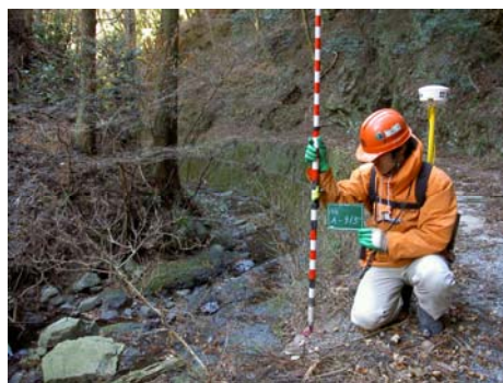
杭の設置・撮影・測量
