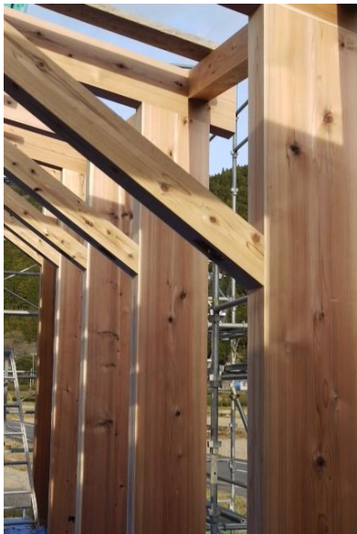
←120mm × 380mm の太いスギの柱が連なる 赤身の強い柱が強固に建物を支えてくれます
